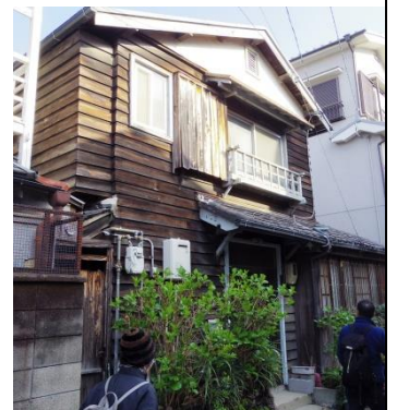
現存する北畠住宅の1棟
