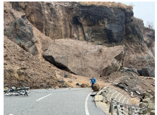
道路をふさぐように崩落した巨岩 (田中純一北陸学院大学教授撮影)
