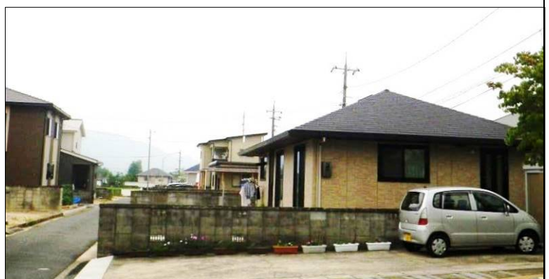
支所庁舎周辺は水没し、その後建てられた家屋ばかり。平屋のリバースモーゲージ住宅も多い
