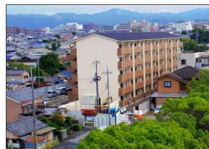
完成間近の宇治市営ウトロ住宅(RC、5F建。バリアフリー、EV付)
