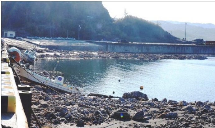
地盤が隆起した鹿磯港
