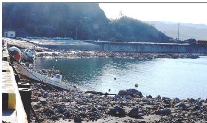
地盤が隆起した鹿磯港
