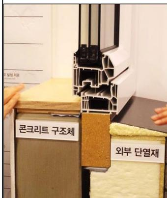
三重窓(上)、複雑な構造の接続部(中)、分厚い断熱材(右下)で気密性を高めている
